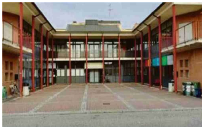
Il complesso della Bovi e dell'adiacente centro diurno. Sotto l'ingresso alla struttura assistenziale
